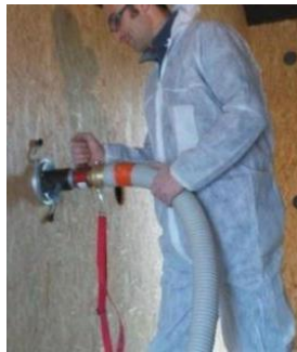
Insufflation isolante en vrac
